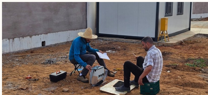
Reconnaissance de sol, chantier de construction
