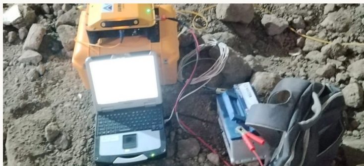
Acquisition ERT sur site rocheux
