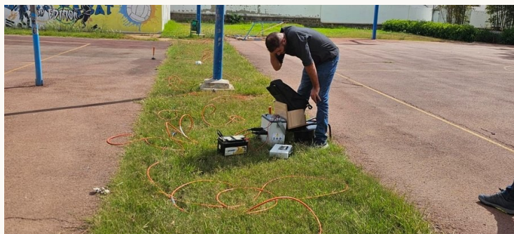
Mise en place d'un profil multi-électrodes
