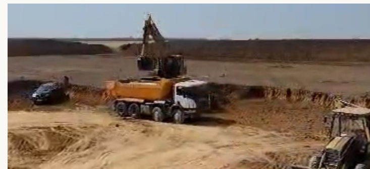
Terrassement d'un bassin de stockage
